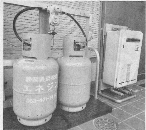
小型ガスボンベで動く仮設給湯器の設置サービスが強み（2月、浜松市）
